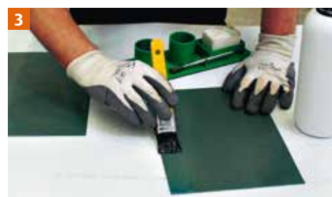
3 Décapage de la couche PIGMENTO® avec du décapant et laissez le produit agir pendant quelques minutes.
