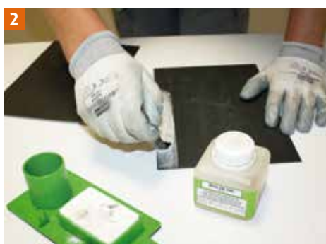
2 Premier décapage au Deca VMZINC.
