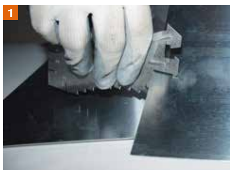
1 Traçage des valeurs de recouvrement.
