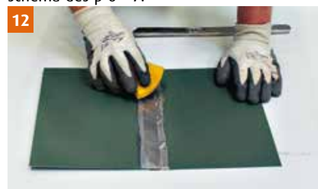
12 Nettoyage du soudo-brasage.
