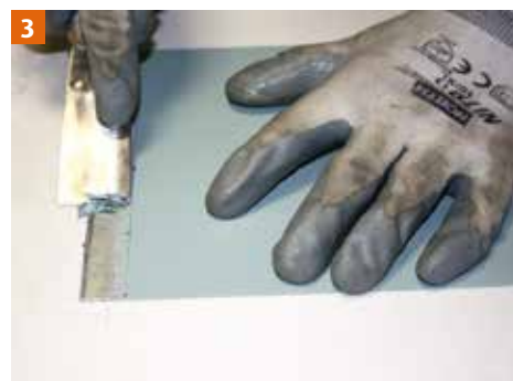
Enlèvement de la laque par décapage chimique.
