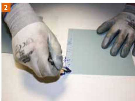
Décapage de la couche bilaquée avec du décapant et laissez le produit agir pendant quelques minutes.
