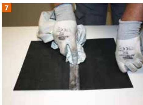
7 Nettoyage du soudo-brasage.
