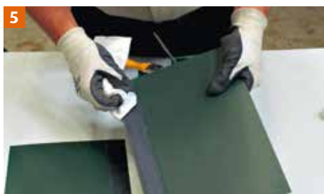
5 Nettoyage de la zone à souder avec un chiffon sec. Répétez si nécessaire.
