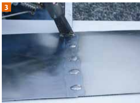
3 Etamage du fer à souder sur la brique d'ammoniaque. Ensuite faire le pointage.
