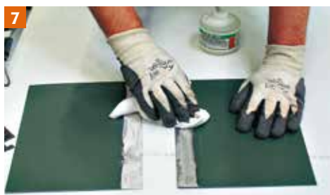
7 Enlèvement de la couche de prépatinage avec un chiffon sec.
