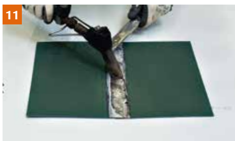
11 Appliquez du Zinn 7 sur la longueur de la soudure. Soudo-brasage des éléments.
