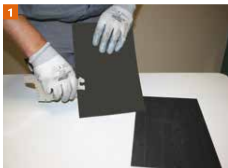
1 Traçage des valeurs de recouvrement.
